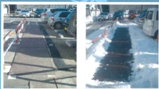
<施工例> 駐車場通路
